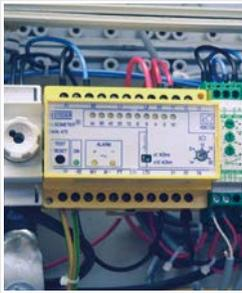
Isolationsüberwachung der 1000V Strecke, Trafo-raum zwangsbelüftet
